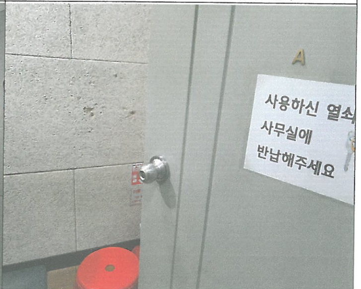
3층 드럼 실 A 도어 손잡이 탈거 되어 제 설치
