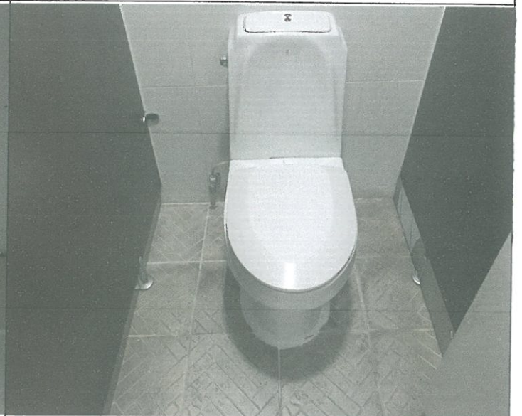
1층 여자 화장실 변기 막힘 해체 통수 시공
