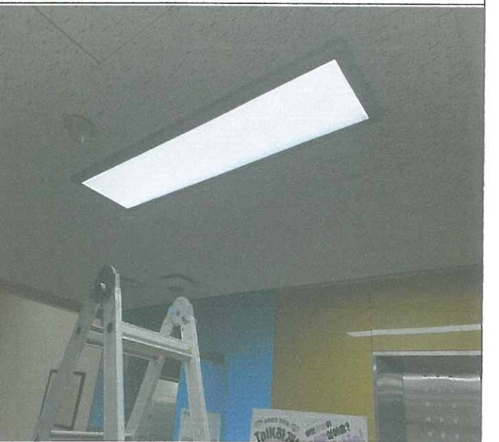
2층 복도 천장 매립 등 1개소 안전기 교체
