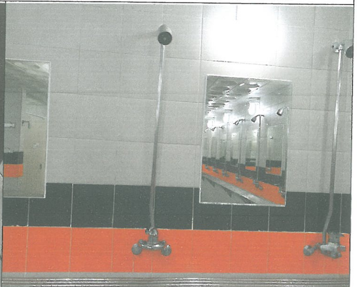
수영장 여자 샤워실 수전 1개소 교체
