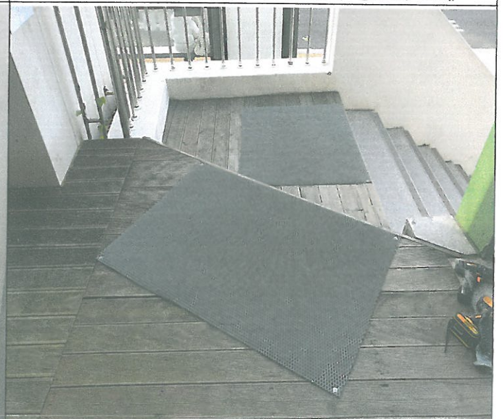
수영장 입구 계단 미끄럼 방지 매트 설치
