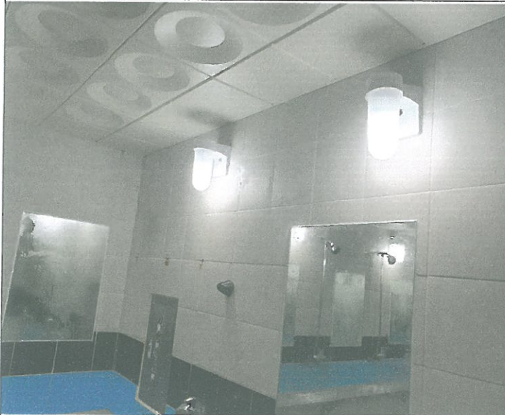
남자 샤워실 전구 1개소 교체
