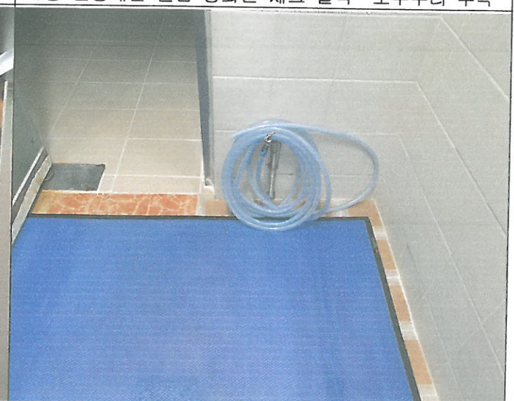
수영장 여자 샤워실 방향 계단 청소용 수도호수 설치
