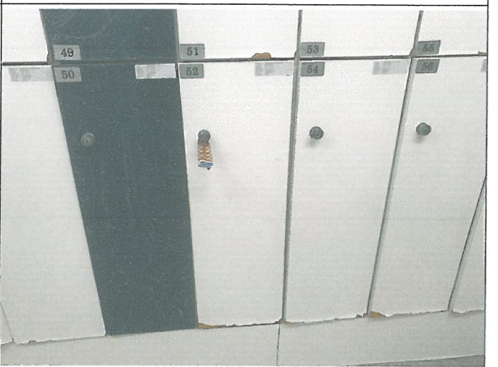
수영장 남자 샤워장 탈의실 락카 경첩 탈거 되어 제 부착
