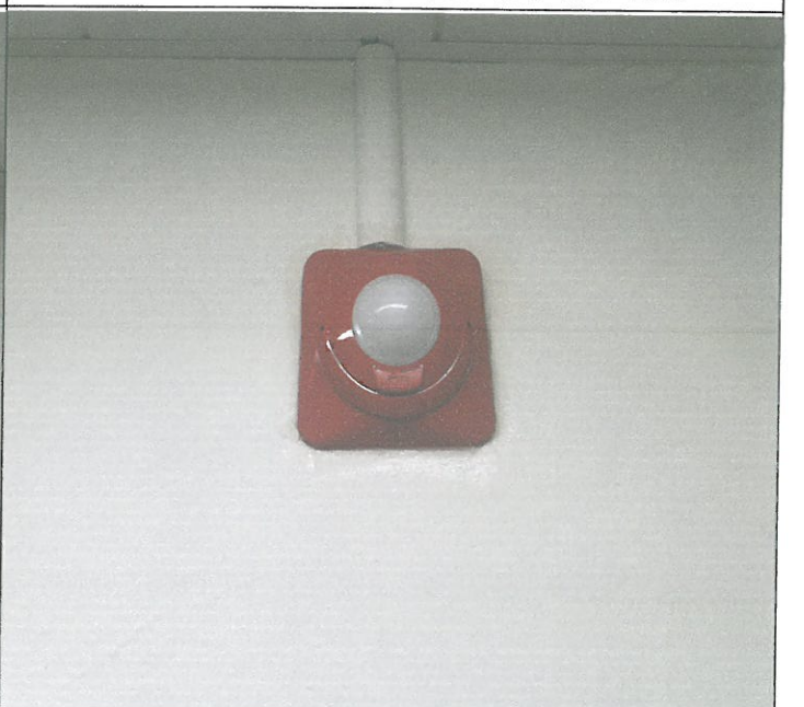
지하 2층 수영장 출입구 방향 시각 경보기 교체
