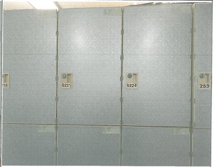
수영장 로비 유료락카 키뭉치 1기 고장 수리
