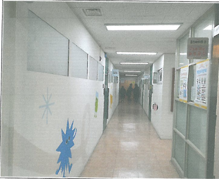
2층 상담 복지센터 복도 및 1층 주차장 출입구 복도 천장 등 격등 공사
