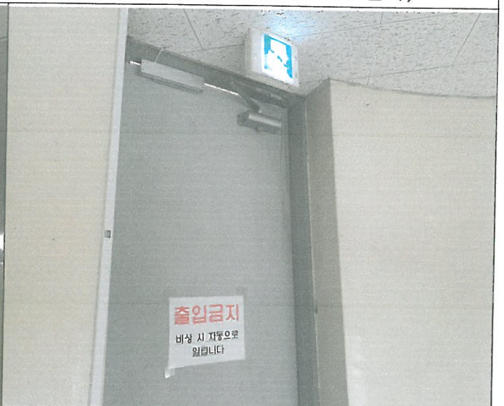
3층 원형계단 출입 방화문 체크 탈락 보수수리 부착
