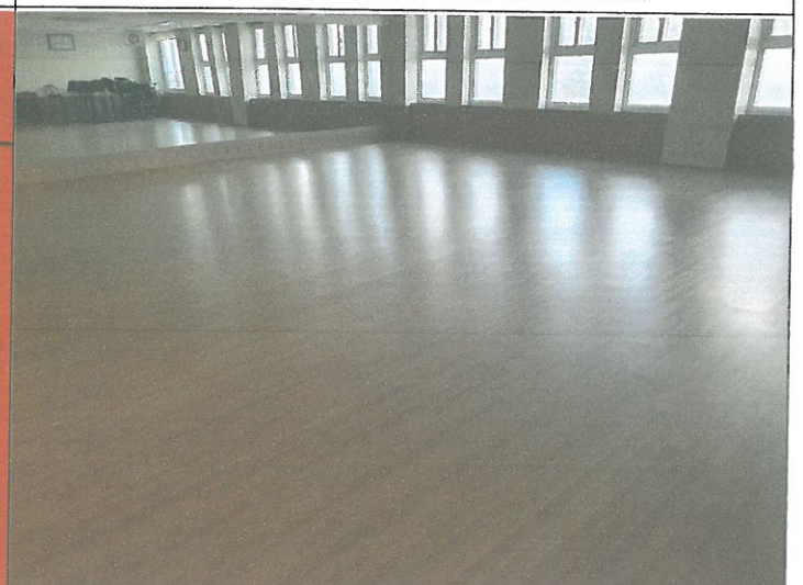
3층 강당 바닥 마루 틈새이격 교정 및 걸래받이 몰딩 정비 교정 시공
