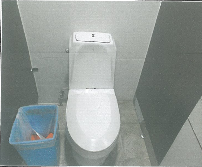
1층 여자 화장실 변기 통수
