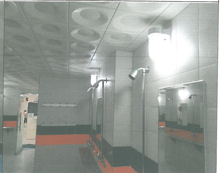
수영장 여자 샤워장 내 벽 등 2개소 전구 교체
