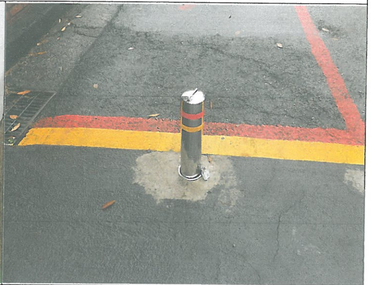
주차 금지 차단 블라드 1개소 파손 교체
