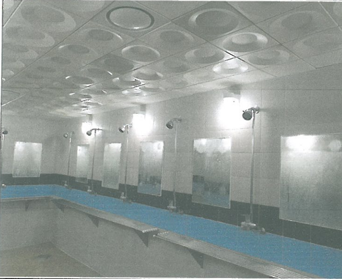
수영장 남자 샤워장 내 벽 등 2개소 전구 교체
