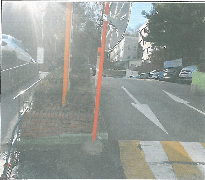
주차장 출입구 반사 거울 시멘트 몰탈
