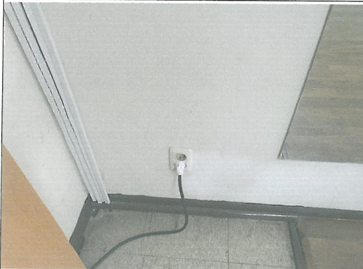
3층 클럽 활동실 벽면 전기 콘셋트 위치 변경 설치 작업
