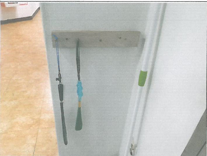
수영장 여자 탈의실 입구 구두손 걸이 제작 설치
