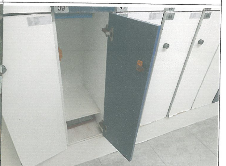
수영장 남자 탈의실 락카 문 경첩 1개소 보수
