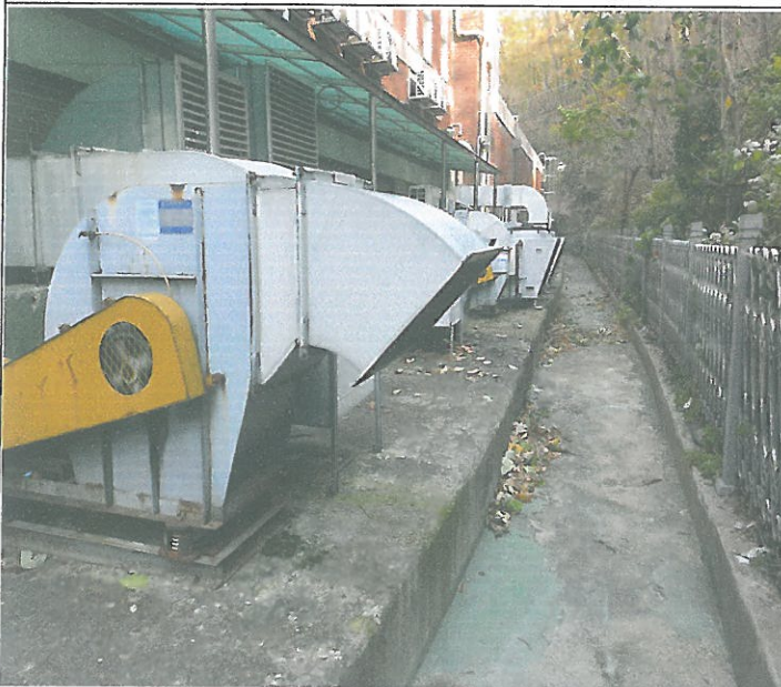
건물후면 각종 배기팬 점검 및 구리스 주입
