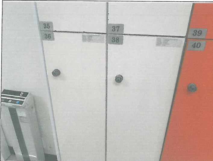
수여장 여자 샤워장 탈의실 락카 1개소 열쇠뿔치 교정 수리
