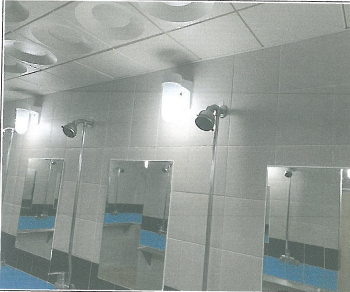
수영장 남자 샤워장 내 전등 1개소 교체
