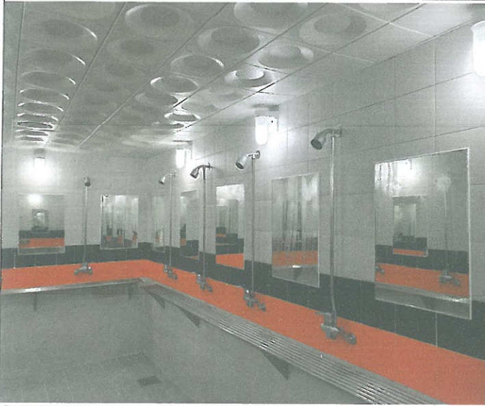
수영장 여자 샤워실 전등 교체
